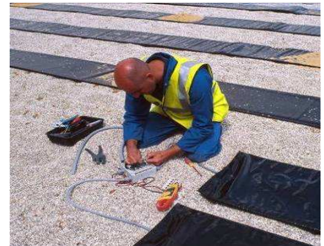
Anschluss von Pads an einen Klemmenkasten
